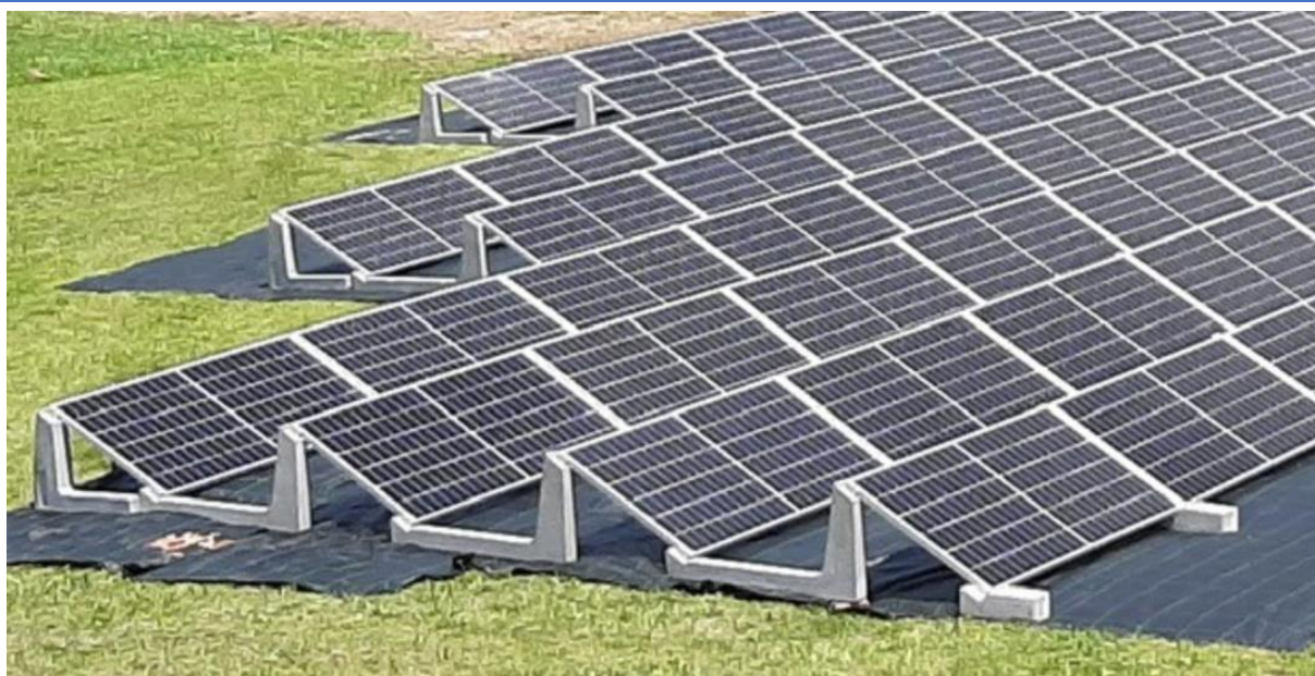
Figura 2 Exemplu montaj panouri pe structura din elemente prefabricate din beton
